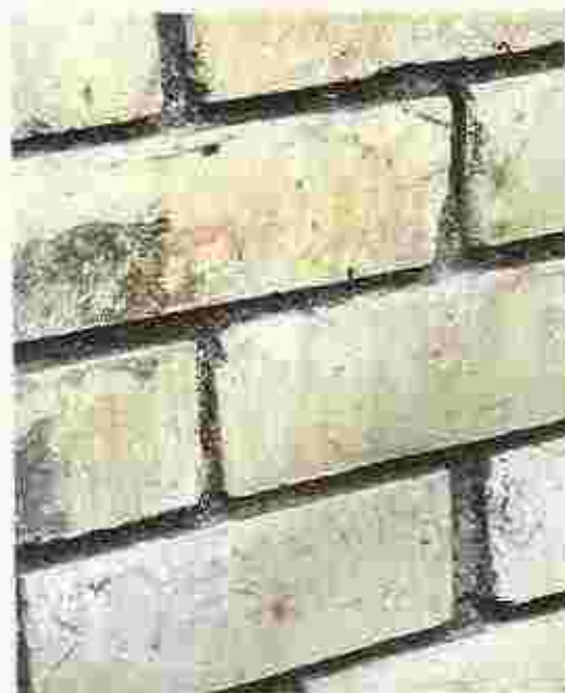
Las juntas rehundidas o ranuradas atrapan más suciedad.
