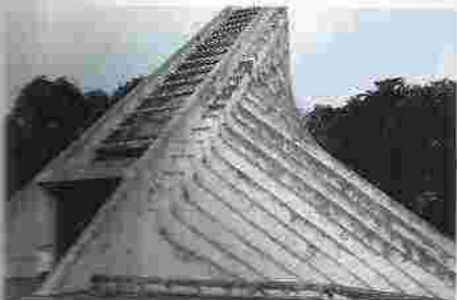
Ejemplos de la evolución a la intemperie de muros que carecen de protección en su tope.
