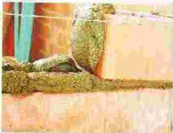
"Mortado" de la cara vertical.
