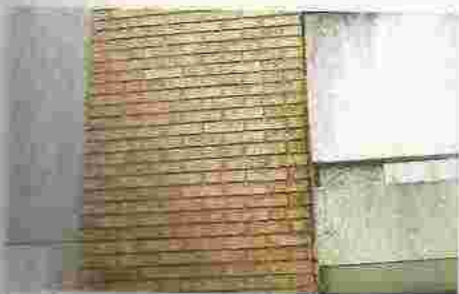
Fotografía 1: aspecto característico de los recubrimientos acrílicos cuando se degradan. Fotografía 2: se puede notar el grado de deterioro del aspecto de los ladrillos, comparando el color de la pencha en el que se efectuó una prueba de restauración, con el resto del muro. Véase el número 2.8 sobre lavado de fachadas.
