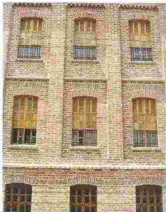
La obra en ladrillo: hermosa y durable.
