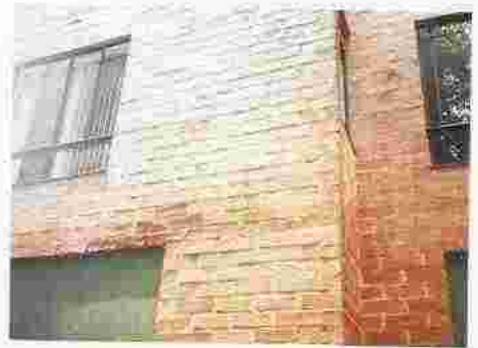
Ejemplos de daños en fachadas originados en humedades provenientes de instalaciones hidrosanitarias del interior de las viviendas.
