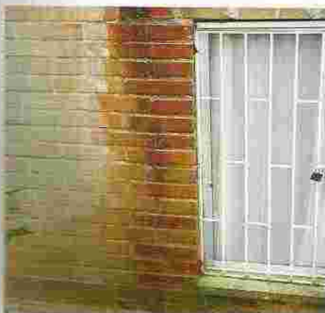
Muchas fallas en el funcionamiento de los sistemas y materiales se originan en errores elementales de diseño o construcción, como los que se muestran en estas imágenes. en Foto inferior derecha: el escorrido continuo de agua por el muro ya ha erosionado el mortero de las juntas de pega y tiene permanentemente húmedos algunos ladrillos.
