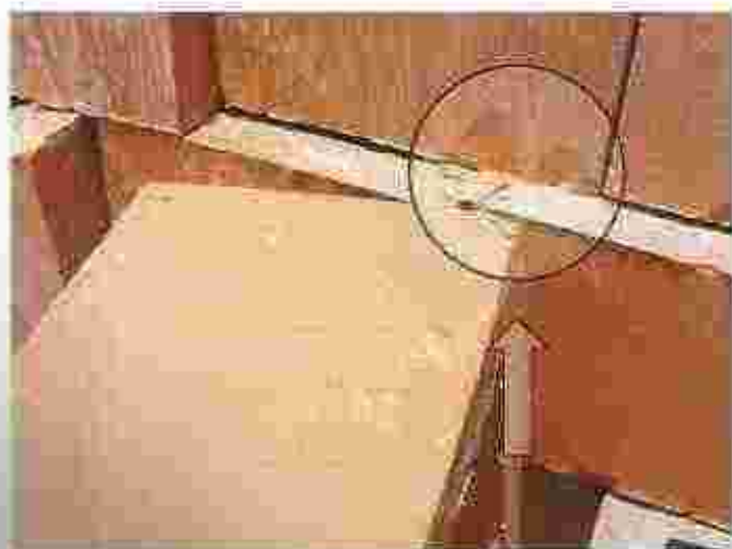
Puntas concentradas en un trazo muy pequeño del ladrillo.
