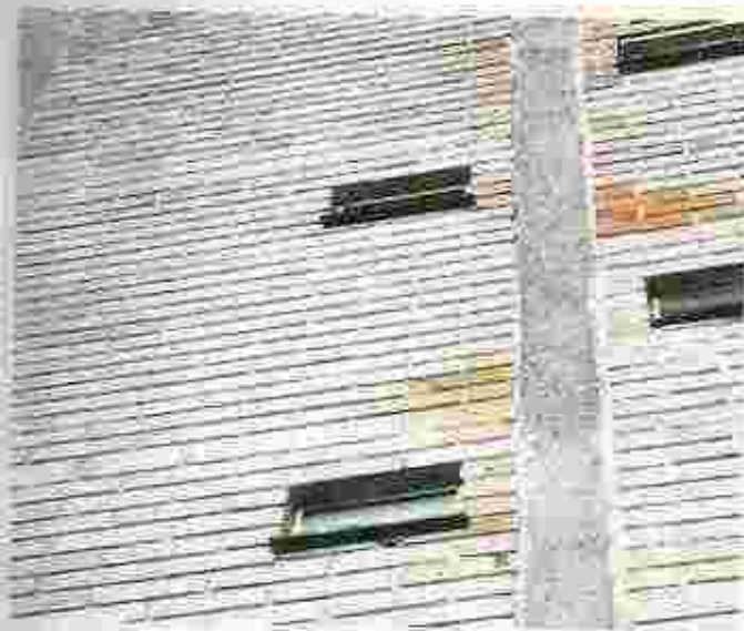
Ejemplos de daños en fachadas originados en humedades provenientes de instalaciones hidrosanitarias del interior de las viviendas.
