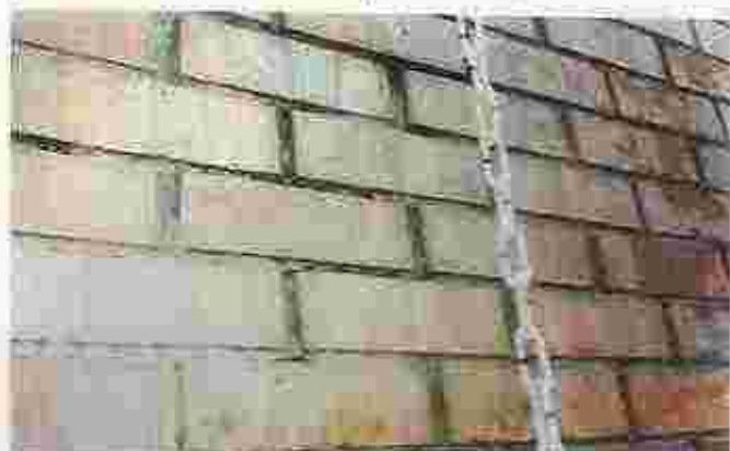
Muchas fallas en el funcionamiento de los sistemas y materiales se originan en errores elementales de diseño o construcción, como los que se muestran en estas imágenes. en Foto inferior derecha: el escorrido continuo de agua por el muro ya ha erosionado el mortero de las juntas de pega y tiene permanentemente húmedos algunos ladrillos.
