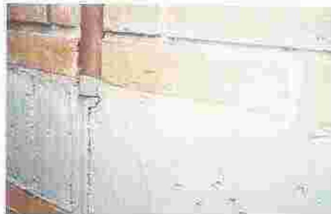
Salpique de una descarga incorrecta de una górgona, a una cuneta perimetral deficiente. Puede ser preferible resolver la descarga de aguas mediante bajantes en vez de górgonas altas.
