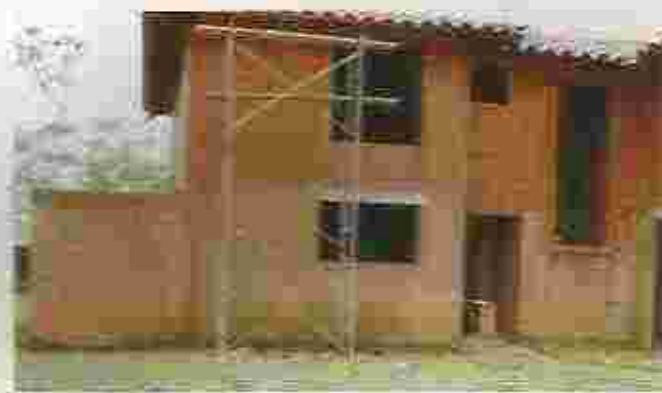
Como la misma etapa de construcción, la obra evidencia las falencias de diseño, como el ensuciamiento por salpique en un muro sin zócalo que se muestra en la fotografía.
