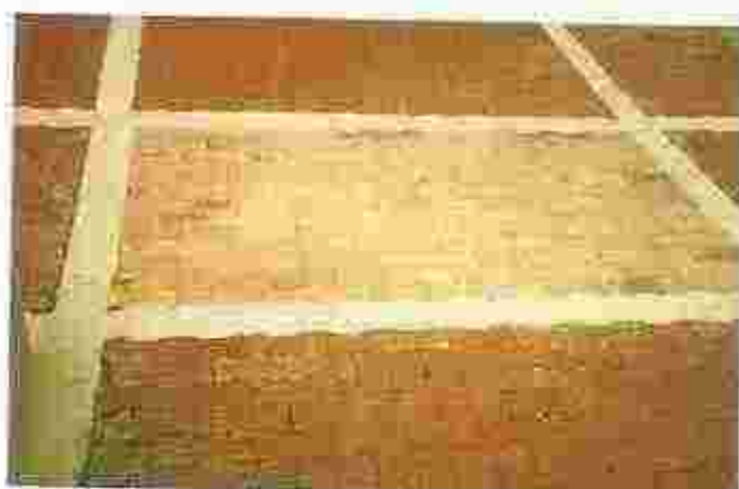
Tramo de adoquín tratado antes de su instalación por inmersión en hidrofugos solubles en agua. Nótese la evolución en comparación con el estado de los tramos instalados sin ningún tipo de protección.
