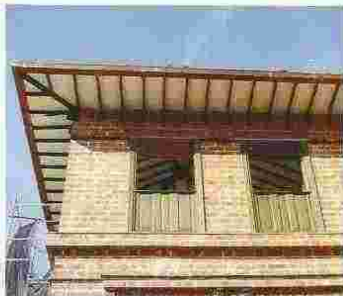
Fachada perfecta después de 105 años: ladrillos, del edificio carré en medellín. Este edificio se empezó a construir en la década de 1.890 y está ubicado en un sitio de fuerte contaminación ambiental.
