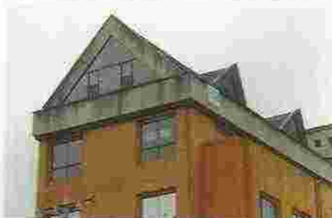
Ejemplos de la evolución a la intemperie de muros que carecen de protección en su tope.
