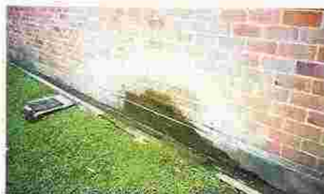
Salpique de una descarga incorrecta de una górgona, a una cuneta perimetral deficiente. Puede ser preferible resolver la descarga de aguas mediante bajantes en vez de górgonas altas.
