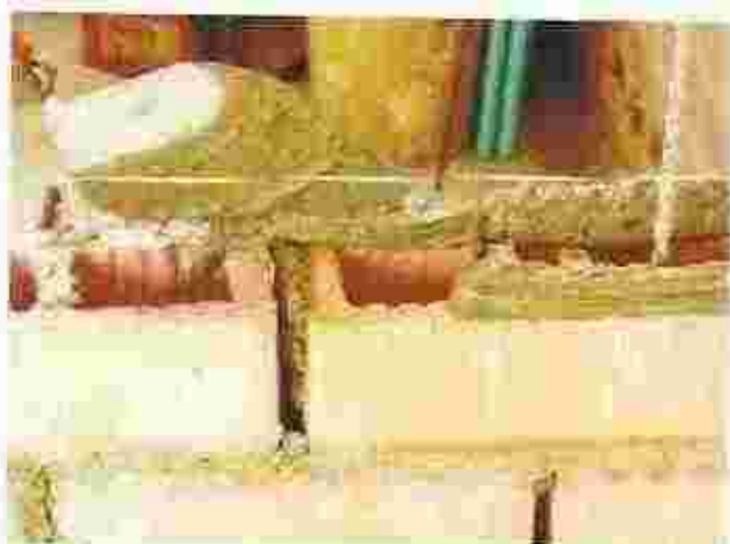
Mortero sobre paredes (pega mínima), esto también se conoce como "mortado".
