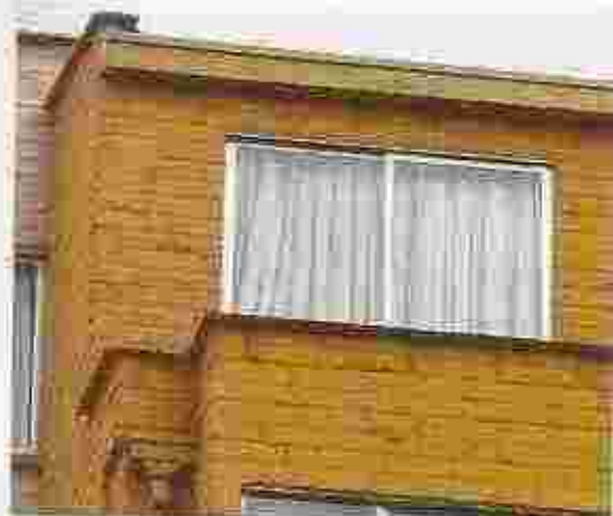
El deterioro de los materiales de fachada se concentran en los sectores de mayor incidencia de viento y lluvia.
