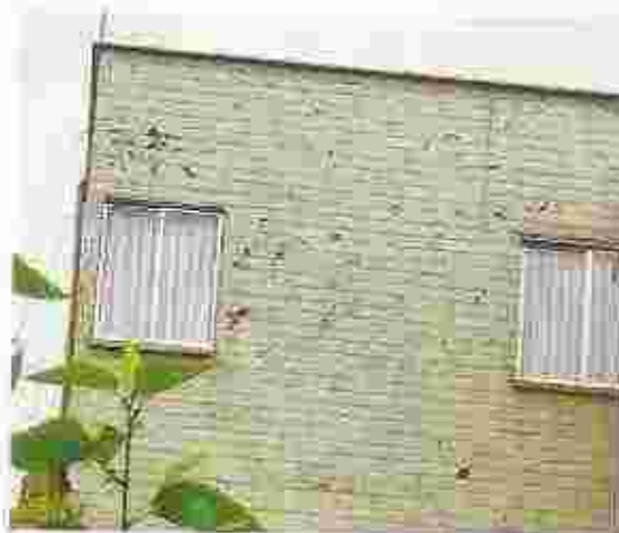
El deterioro de los materiales de fachada se concentran en los sectores de mayor incidencia de viento y lluvia.
